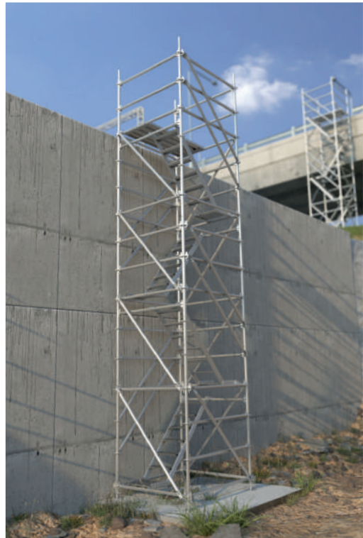
Accès au chantier tour d'escalier
