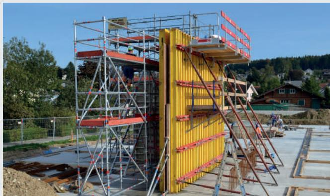
Sécurité garantie durant le bétonnage grâce aux protections latérales.
