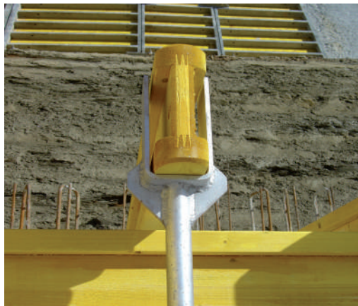
Montage traverse avec fourche de pose H20
