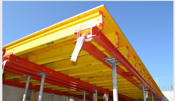
Etais autobloquants grâce au système innovant de serrage par clavette.
