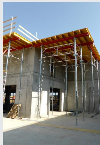
Soutien avec des étais jusqu'à une hauteur de 7,25 m.
