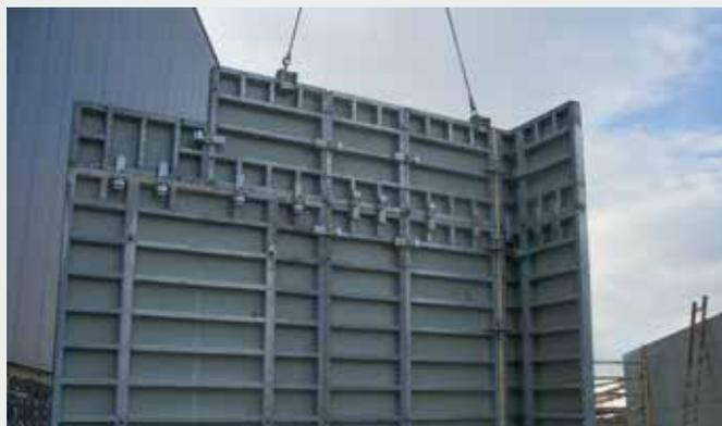
Die robuste Ausführung erlaubt die Vormontage und den Krantransport von grossflächigen Elementen.
