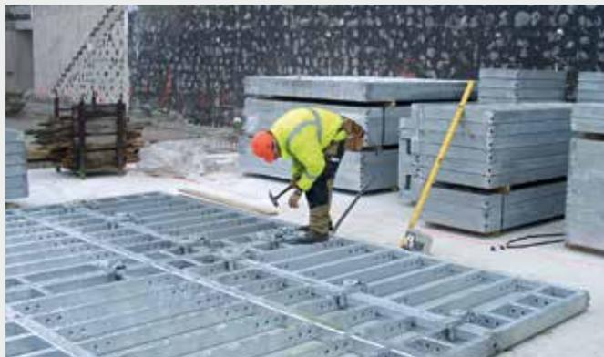
Die einfache Vormontage am Boden bietet hohe Flexibilität und ermöglicht einen sicheren Einsatz der Grossflächen-Elemente.
